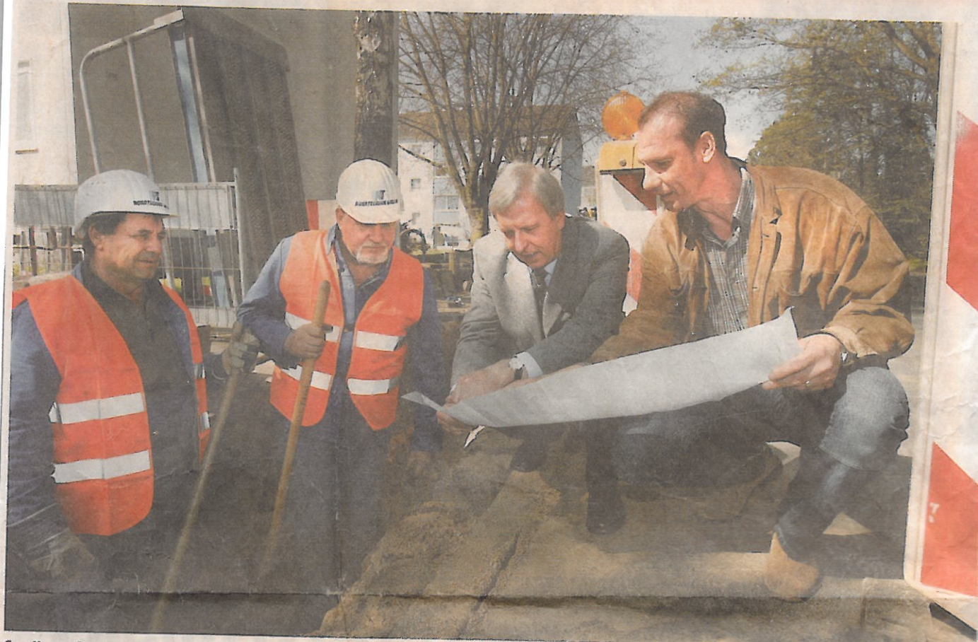
Studieren Pläne: Stadtwerke-Geschäftsführer Dirk von Lojewski (2.v.r.) und Bauleiter Martin Gregor (r.) mit Bauarbeitern. Noch bis 2007 tauschen die Stadtwerke, wie hier am Magnolienweg, Grauguss- gegen Kunststoffrohre aus.
