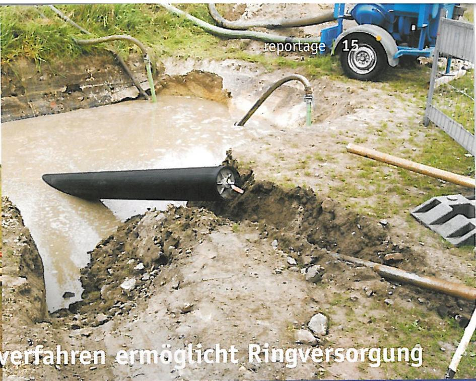
Auf'm Reck: Spülbohrverfahren ermöglicht Ringversorgung
