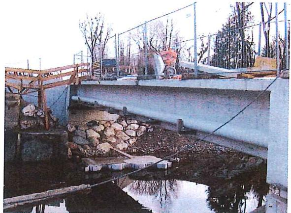
Abb. 4 – Aufhängung der Erdgashochdruckleitung im Brückenbereich
