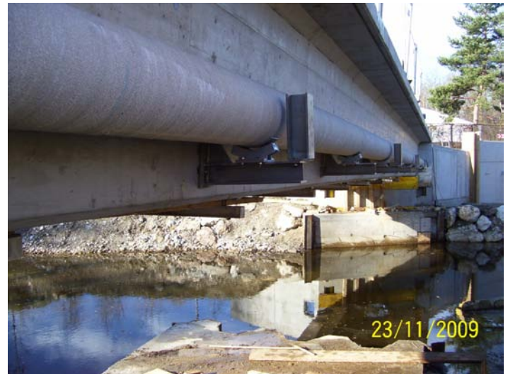
Abbildung 8. Tragkonstruktion Erdgas HD Glanbrücke.
