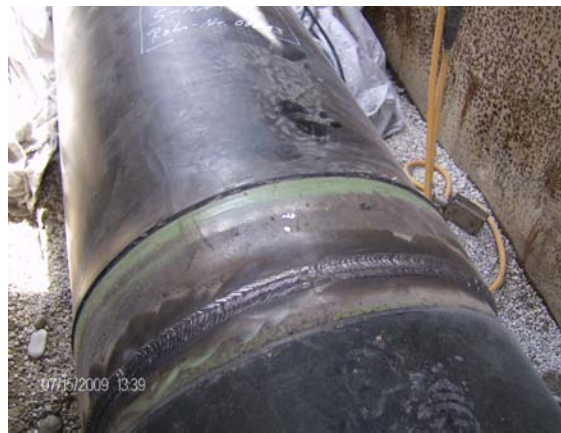
Abbildung 2 Schweißnaht, Kehlnaht
