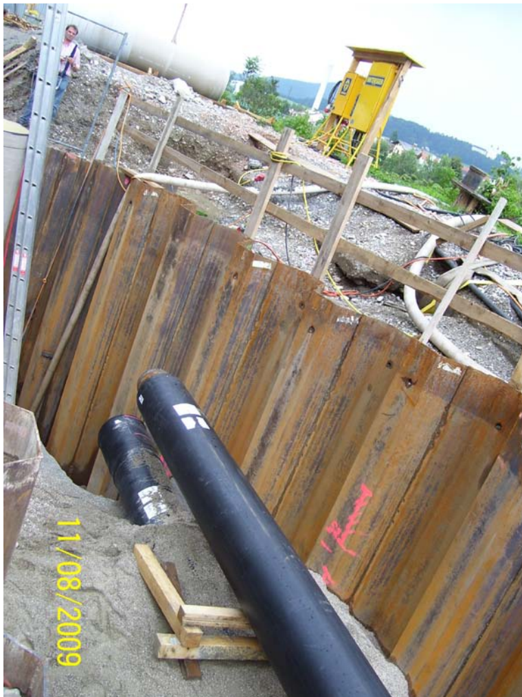
Abbildung 10 . Stockbauweise Fernwärmeleitung DN 300 DA 450
