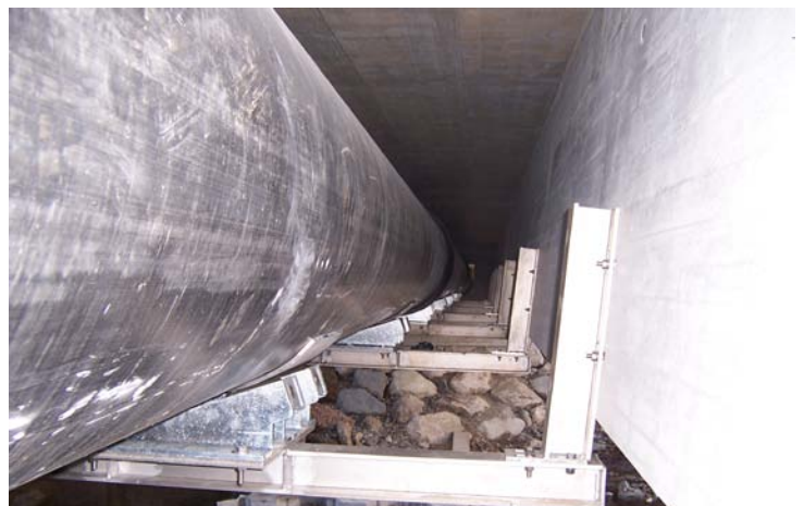
Abbildung 5. Halterung im Brückenbereich
