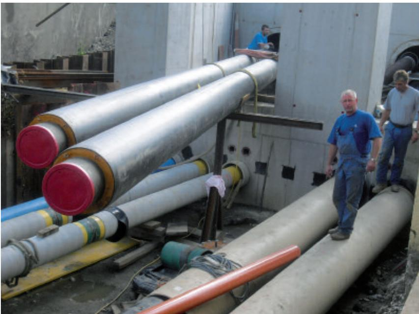
**Abb. 5** Verlegung außerhalb des Startschachts
