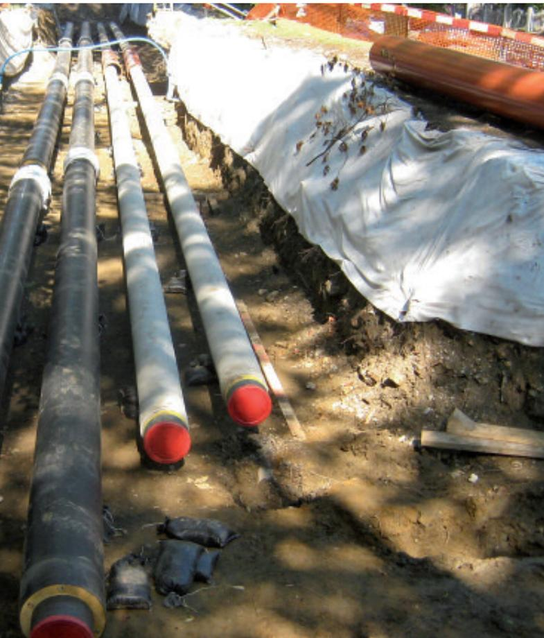
**Abb. 3** Verlegung der Gewerke Gas, Wasser und Fernwärme vor der Häuserfront Saint-Jullien-Straße (Wasserleitung nicht im Bild)
