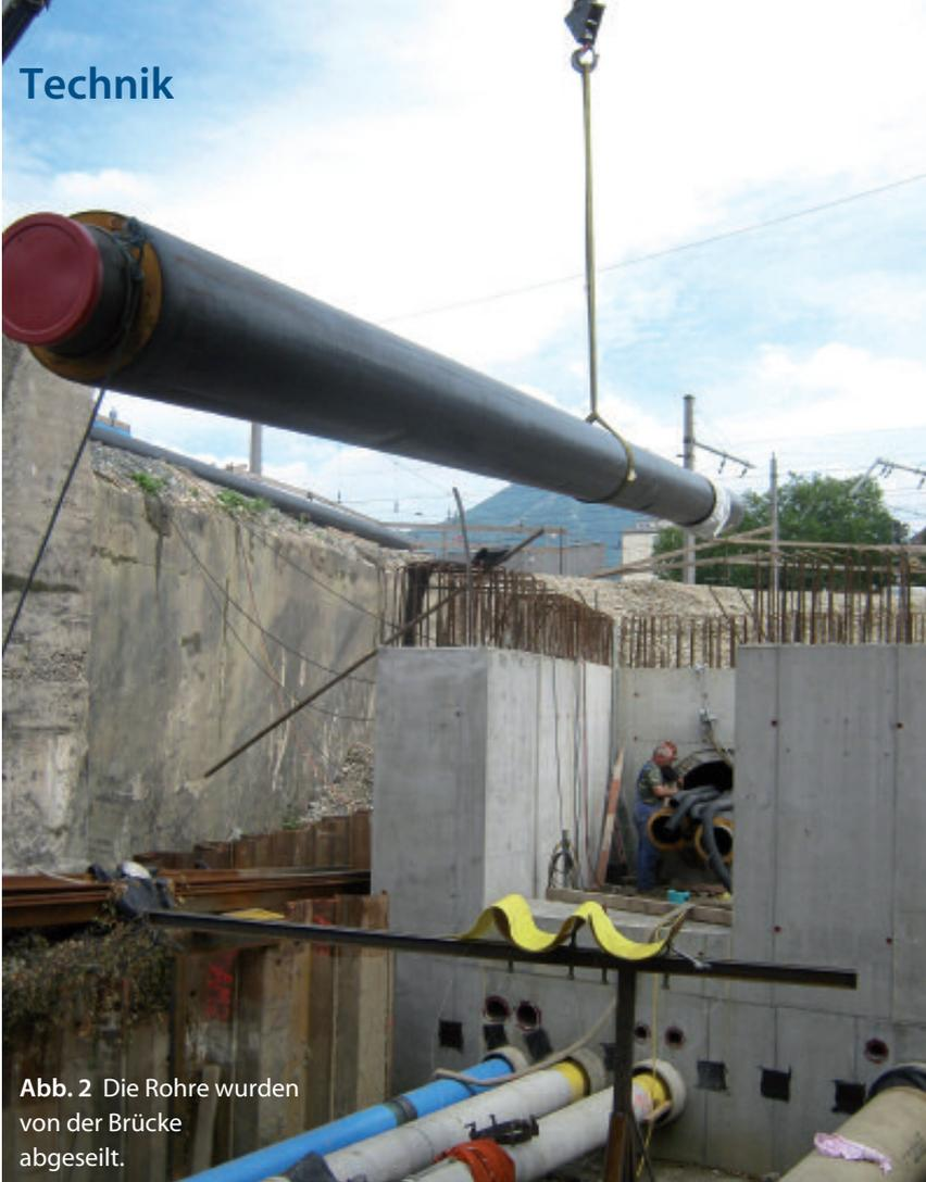
Abb. 2 Die Rohre wurden von der Brücke abgeseilt.
