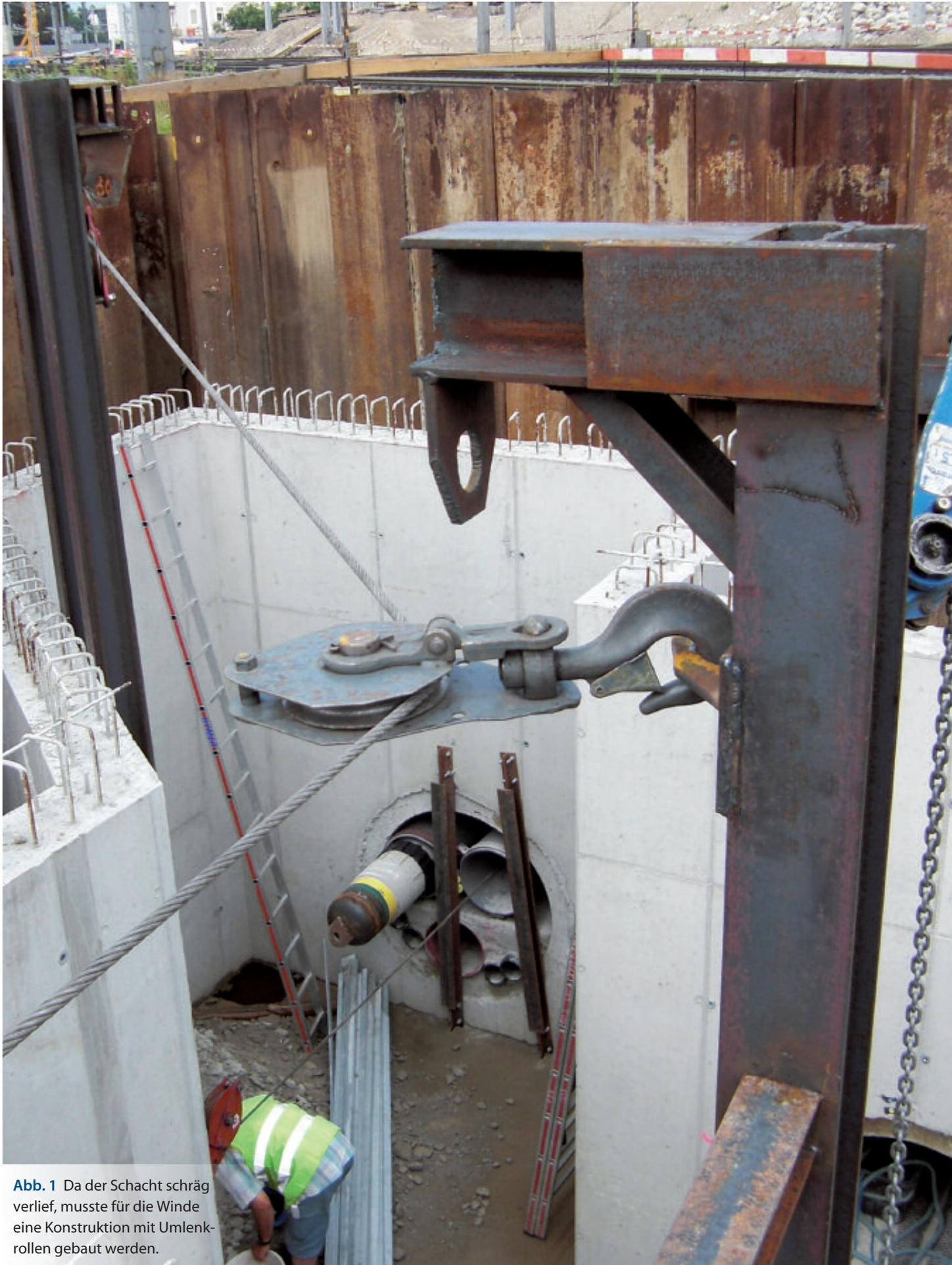
**Abb. 1** Da der Schacht schräg verlief, musste für die Winde eine Konstruktion mit Umlenkrollen gebaut werden.
