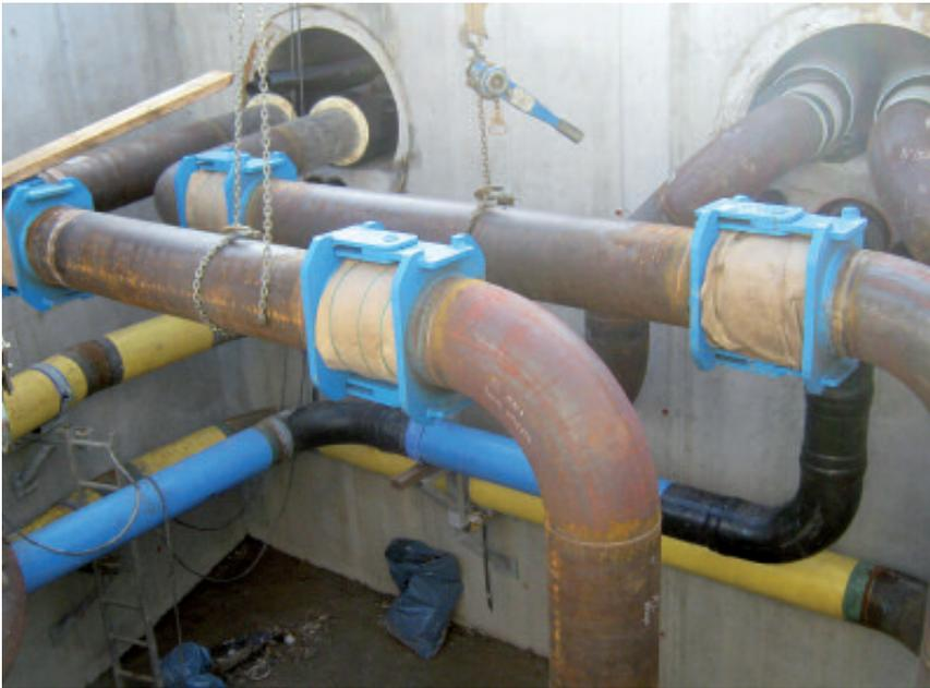
**Abb. 4** Verlegung im Startschacht: Gas, Wasser und Fernwärme
