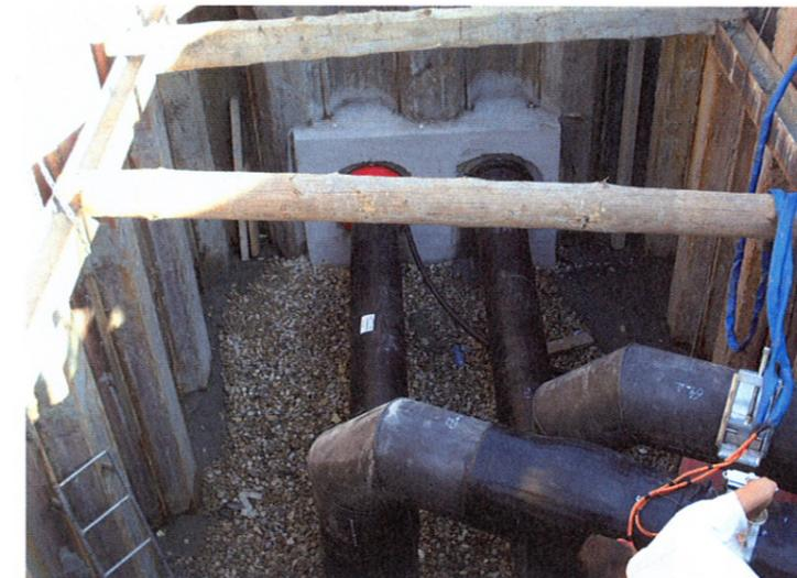
Abb. 2 Pressgrube der Isolierarbeiten mit Elektroschweißmuffen DN 250/Da 400 und Betonabschottung gegen Wassereintritt
