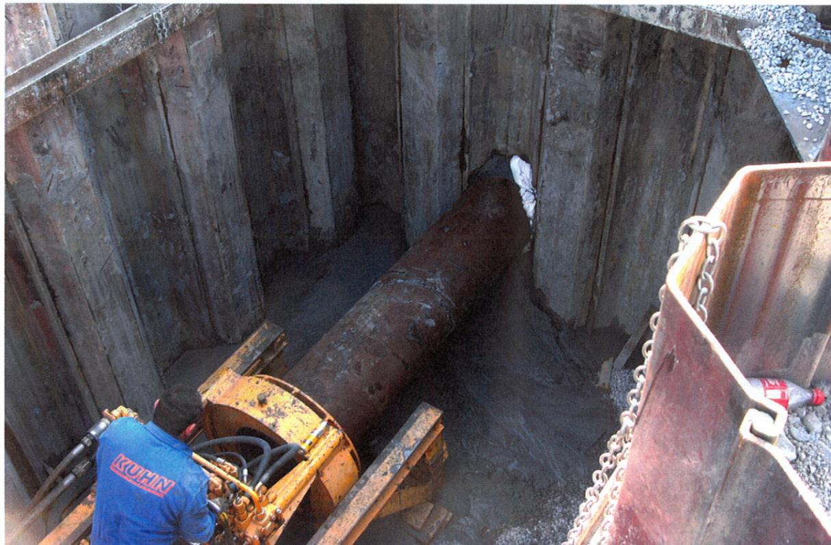
Abb. 1 Press-Schneckenvortrieb in der Startgrube im Bereich der Bahnunterquerung
