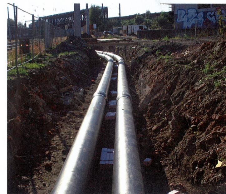
Abb. 3 Trasse im Bahnbereich der ÖBB. Die Fernwärmeleitung wurde mit Sandsäcken unterlegt.
